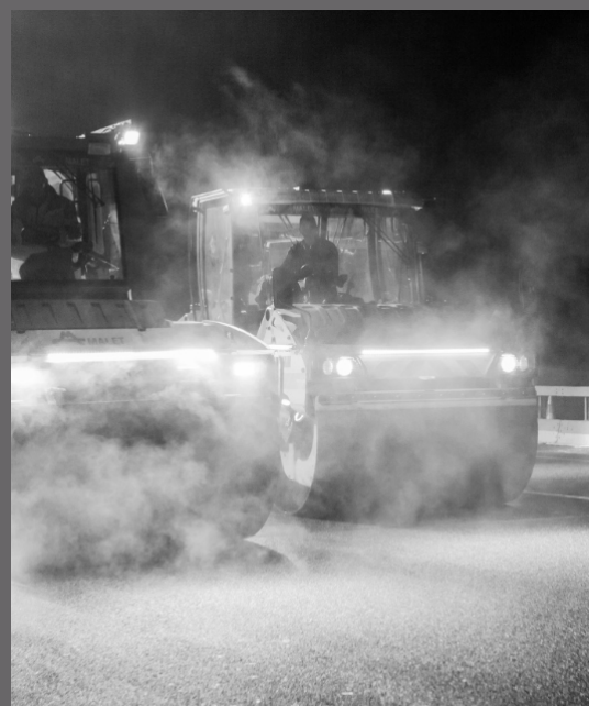
Engins de chantiers
