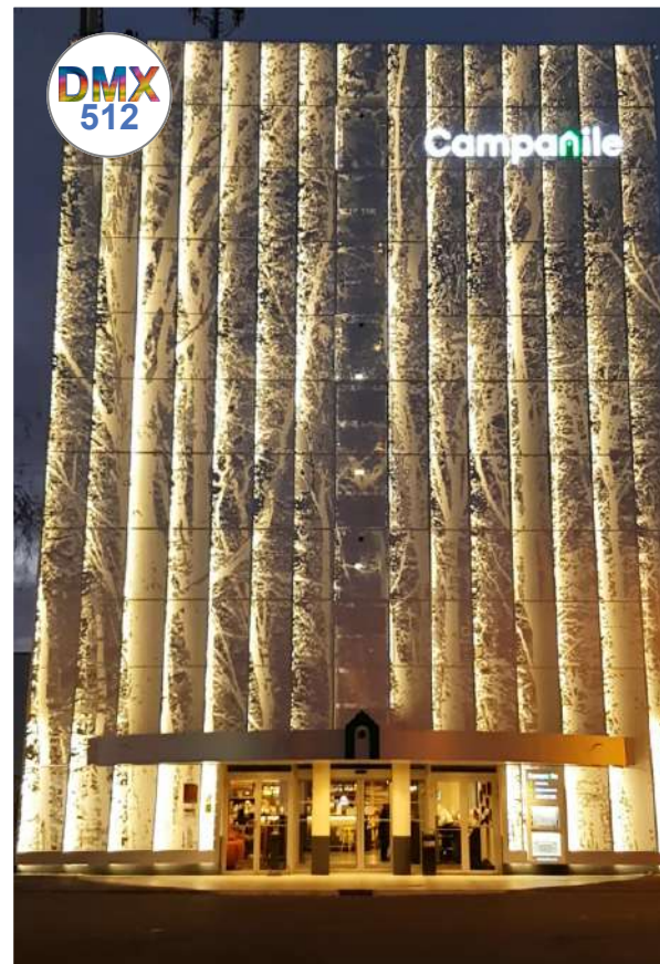
Pilotage DMX d'une façade d'un hôtel.
